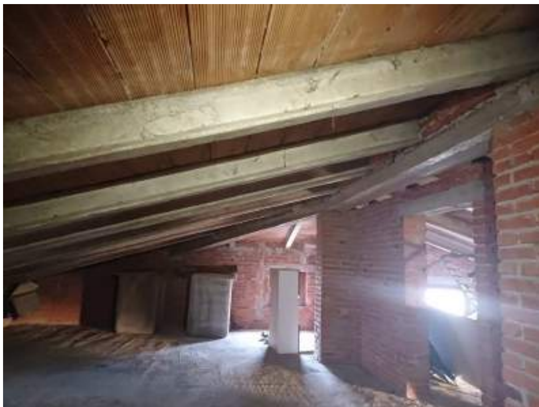
Foto n. 18. Lotto n. 1. Vista interno compendio immobiliare esecutato, Rif. Immobile indicato con Lettera: A, Comune di Tuoro Sul Trasimeno, Via Fonte n. 8, Catasto Fabbricati, Foglio n. 17, Part. n. 412 Sub 3, P.T-2-3 (Appartamento al P.2). Soffitta al P.3 annessa all'appartamento posto al P.2
